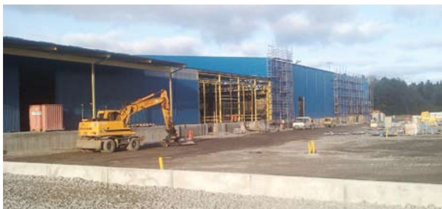
Строительство склада «Stufningsmagasin» в городе Гавле (Швеция)
