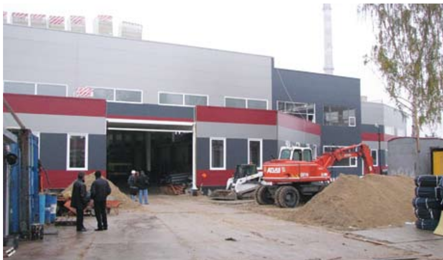
Строительство автосервиса «39 Авто» в Калининграде (Россия)
