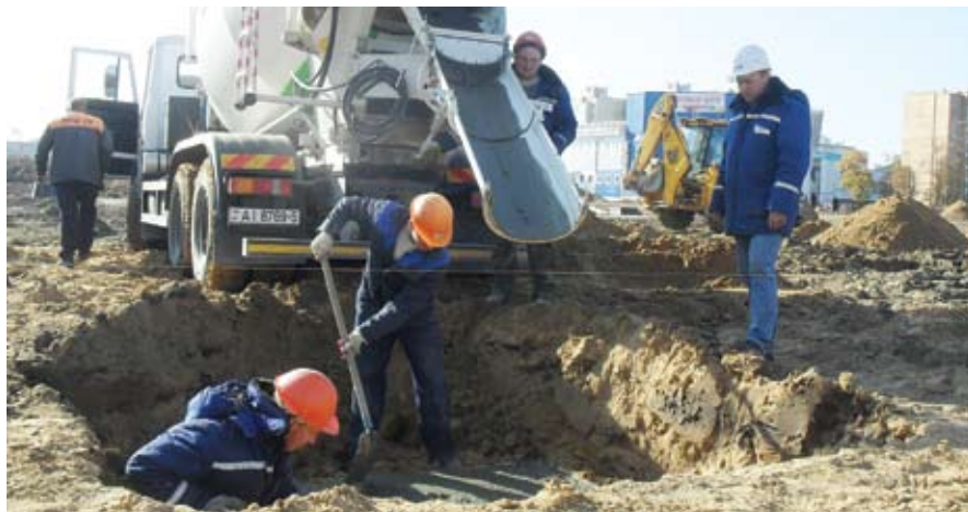
Строительство торгового и развлекательного центра в городе Солигорск (Республика Беларусь)
